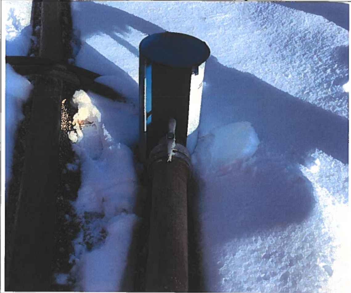
Abbildung 4: Sickerbrunnen einer bauzeitlichen Wasserhaltung
